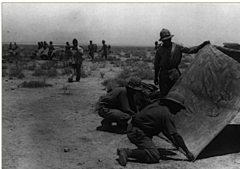
Soldati italiani in sosta sul fronte di Tobruch. Nord Africa. Estate 1941. Archivio Centrale dello Stato, Roma
